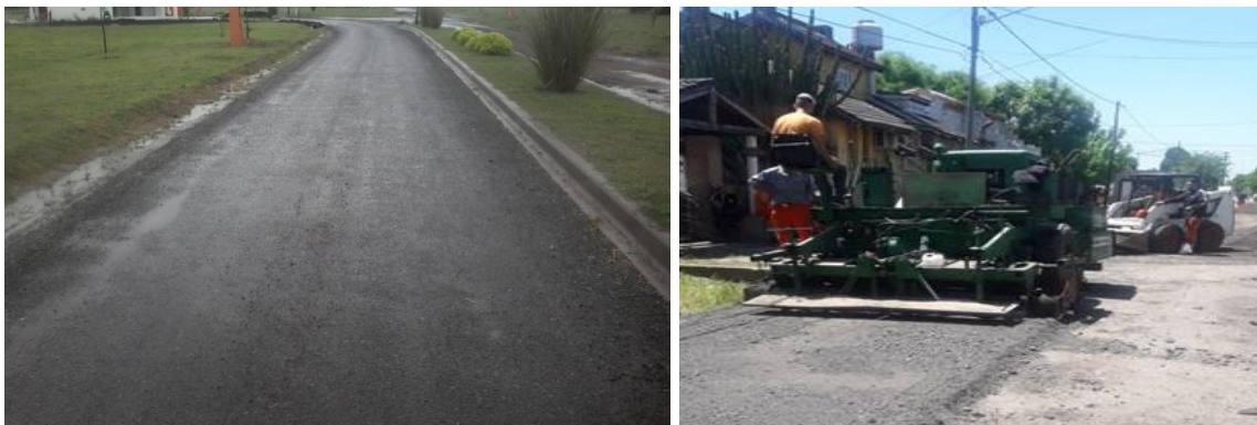
Figura 3. Empleo de RAP más aceite usado de motor y distribuido con terminadora en una urbanización (izq.) y en el Conurbano de Buenos Aires (der.)
