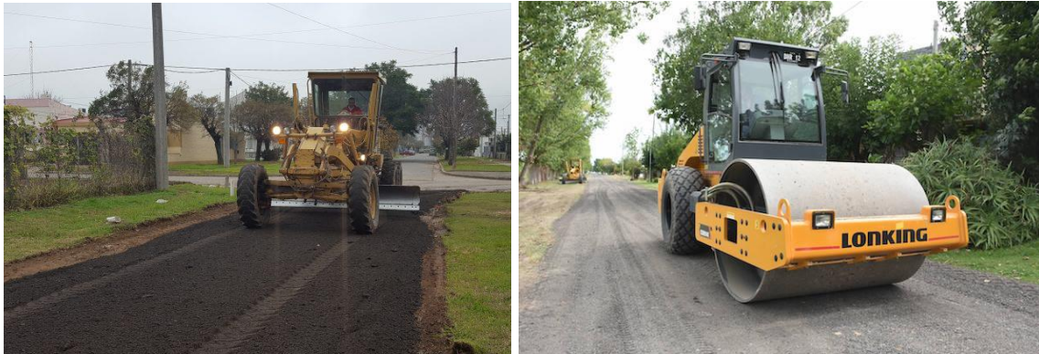
Figura 1. Empleo de RAP solo, en una zona suburbana en el Municipio de Rojas (izq.) y en el Municipio de Berisso (der.)
