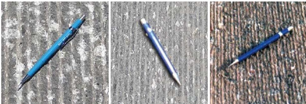
Figura 5. Fresado estándar (izq.), fresado fino (centro) y microfresado (der.) [6]
