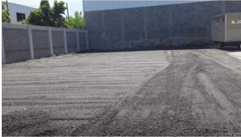
Figura 4. Empleo de RAP más aceite usado de motor, distribuido con terminadora en una playa de estacionamiento en Conurbano de Buenos Aires
