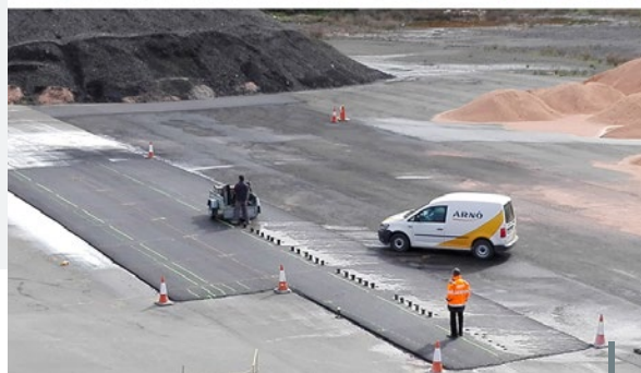
Fotografías 3 y 4. Construcción del primer tramo experimental.
