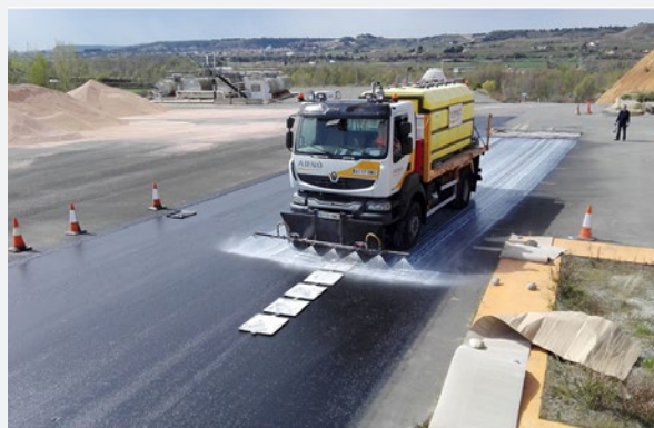
Fotografías 1 y 2. Lechadas de cal como protección de riegos de liga.
