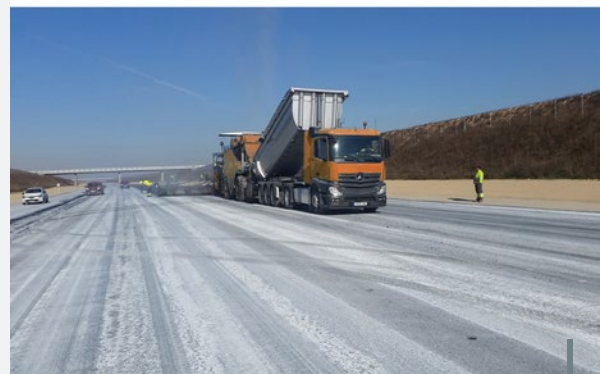
Fotografías 1 y 2. Lechadas de cal como protección de riegos de liga.
