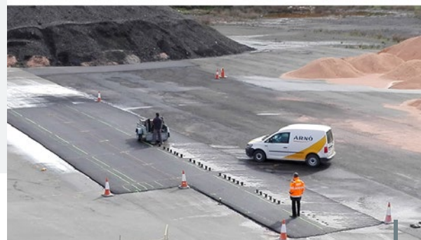
Fotografías 3 y 4. Construcción del primer tramo experimental.
