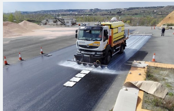
Fotografías 1 y 2. Lechadas de cal como protección de riegos de liga.
