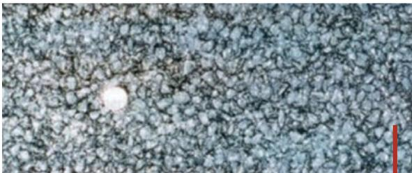
Fotografía 4. Aspecto del pavimento terminado. Obsérvese la elevada macrotextura.
